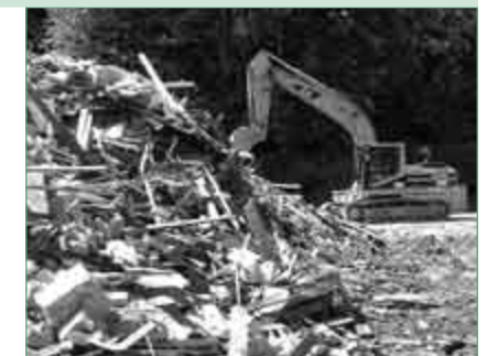
Anfang Juni wurden die alten Steine bereits abtransportiert.
